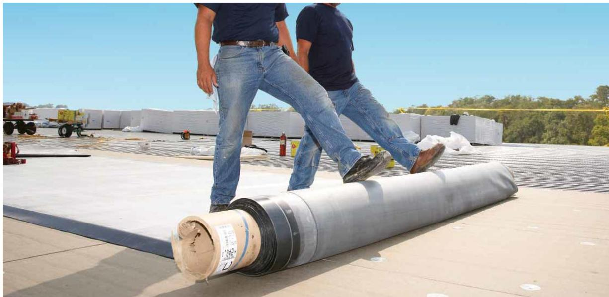
EPDM Dachfolie mit CE-Zulassung als Rollenware in verschiedenen Breiten, als Rolle oder fertig zugeschnitten und kommissioniert ständig am Lager.
